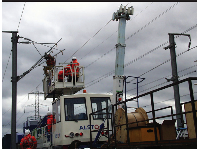
Übersetzungs und Schwingungs Teleskopmast für die finale Leitungs-Positionierung (opt. 131.1)
